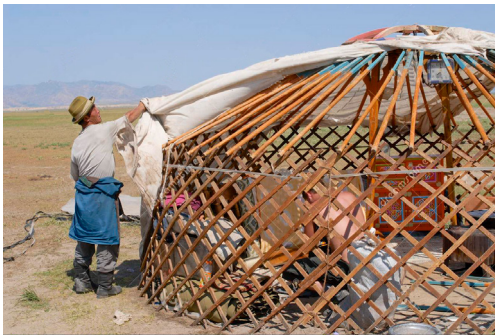
Imagen 6. Instalación de Yurta en estepa mongola.
