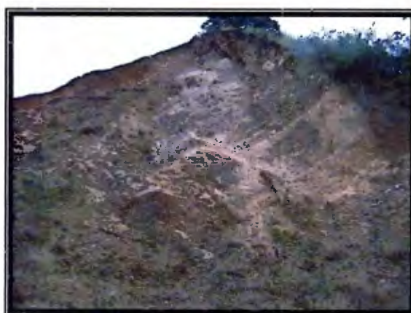
Figura N°2.14 Vista frontal del Deslizamiento de Guatuso (coordenadas 201.150N/543.650W, hoja Tapantí)
