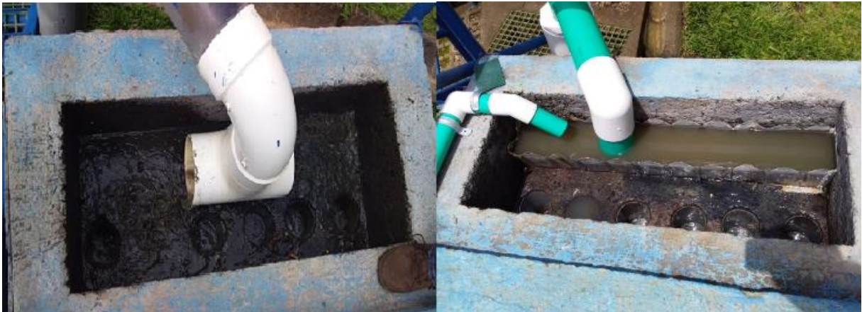
Figura 37. Distribución de entrada al reactor UASB, antes y después de la colocación de los vertederos.
