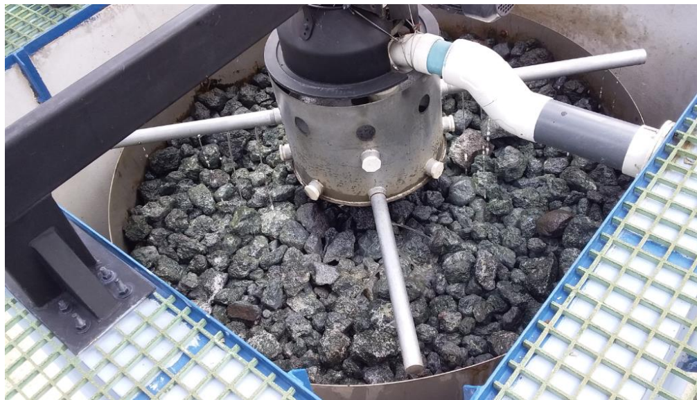
Figura 47. Zona superior del filtro previo al cambio del material de soporte por esponjas.
