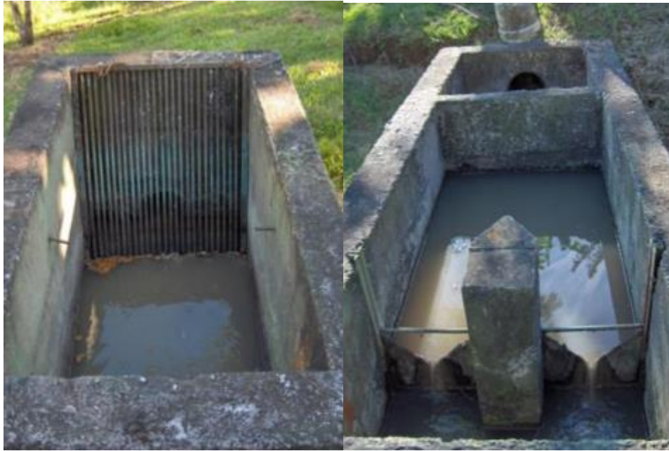
Figura 32. Caja de rejillas y vertederos, previo a las modificaciones realizadas
