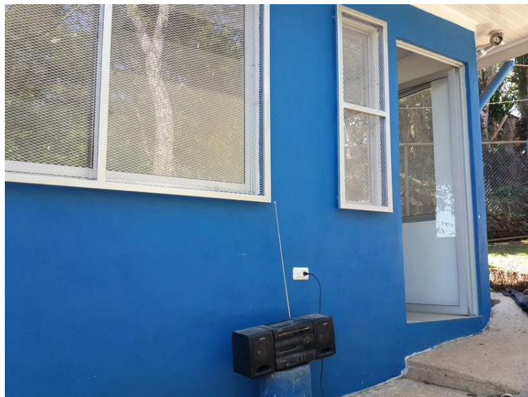
Figura 53. Caseta de operación de la PTAR
