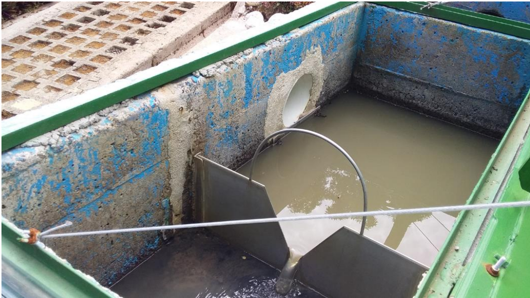
Figura 35. Vertedero triangular del sedimentador primario
