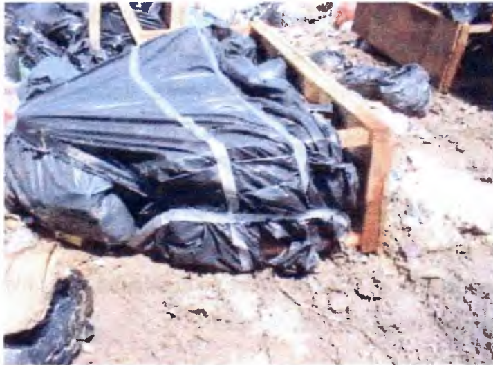
Fotografía 8. Deposito de bolsas con materiales que poseen asbesto
