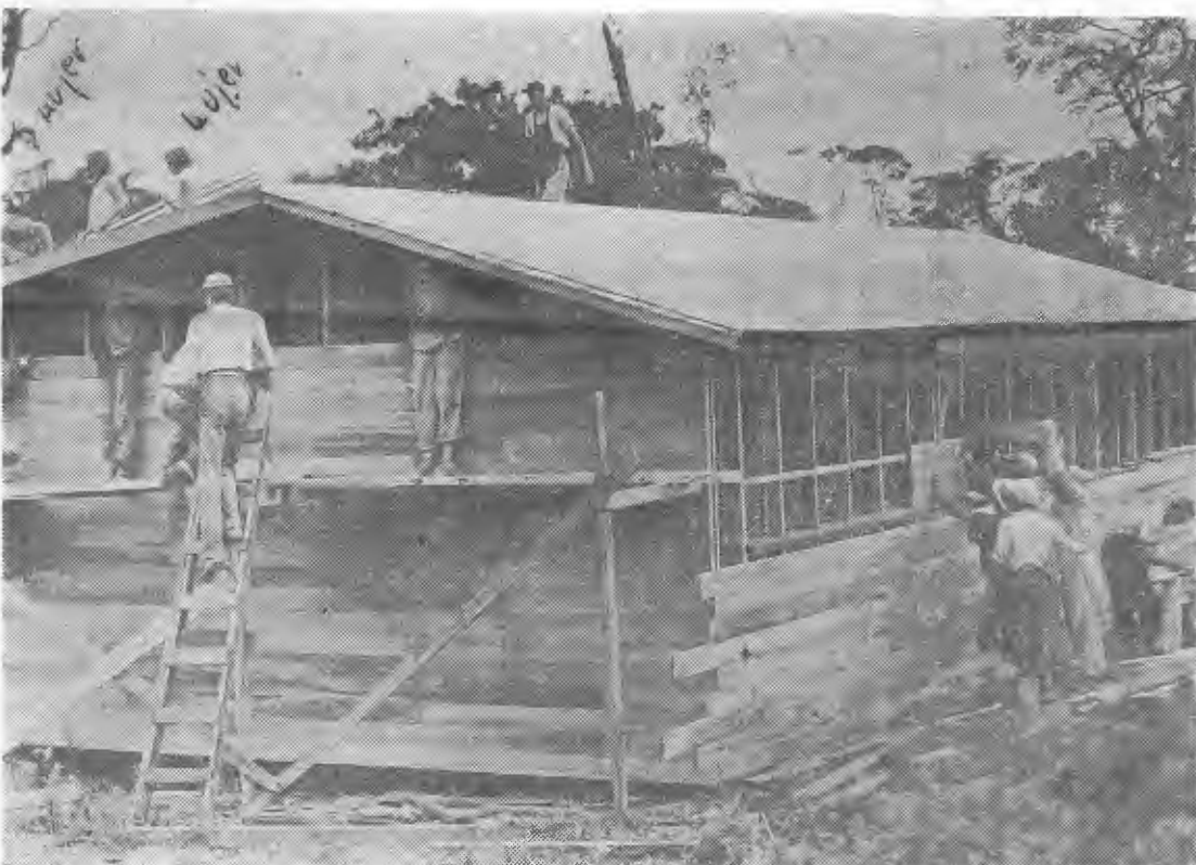
Un vecino necesita casa, y todos acuden a ayudarlo en la construcción. Obsérvese que hasta las mujeres trabajan (sobre el techo) para contribuir a terminar rápidamente la vivienda.
