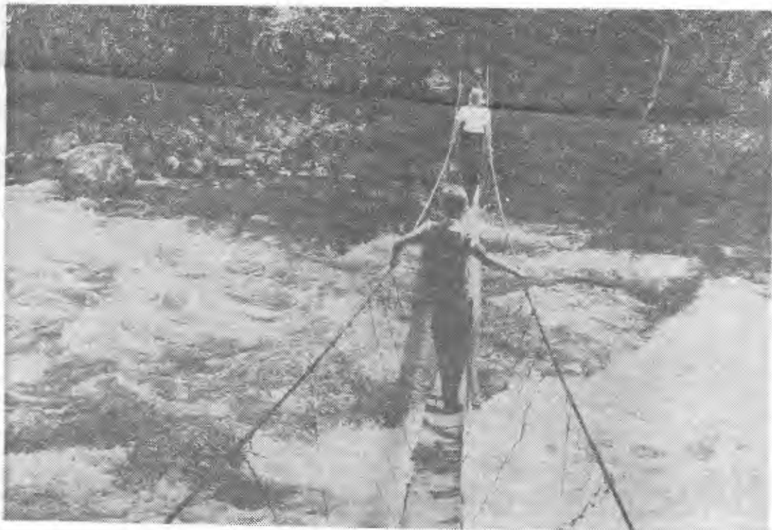
El Ceibo, un río peligroso, aísla a Ujarrás. Sólo existe este puentecillo de hamaca; las tablas, sostenidas por delgados alambres, son un constante peligro para los indios que es ven obligados a utilizar este paso.
