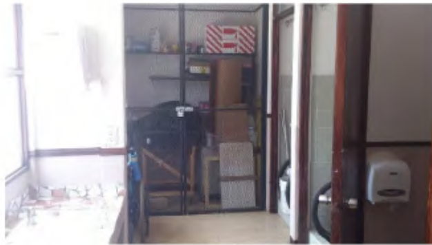
Imagen 4.1: SS previos a remodelación. Fuente: Propia (noviembre 2013)
