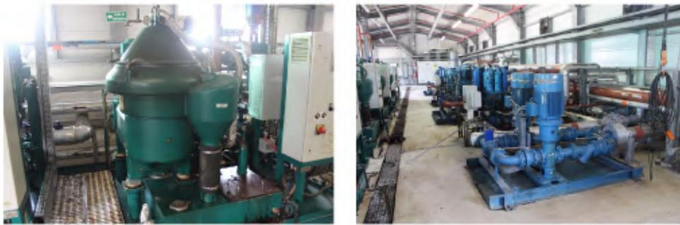
Figura 9.10: Bombas centrífugas de purificación. Fuente: Elaboración propia (2015)
