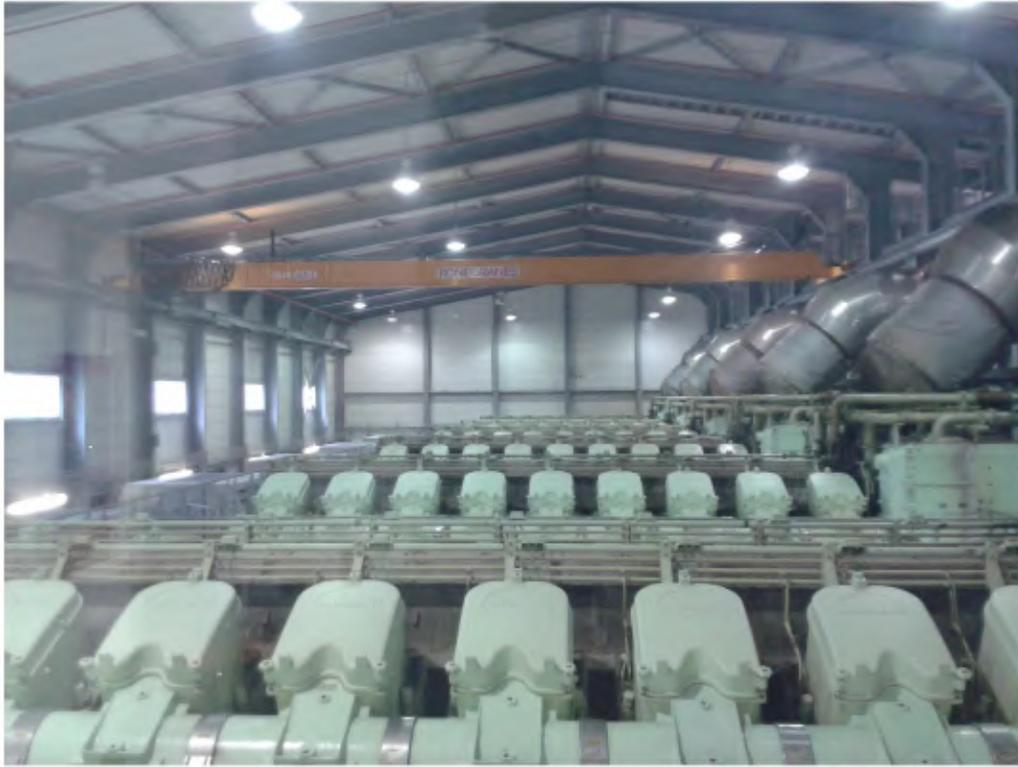
Figura 9.9: Casa de máquinas con motores de combustión interna recíprocos. Fuente: Elaboración propia (2015)
