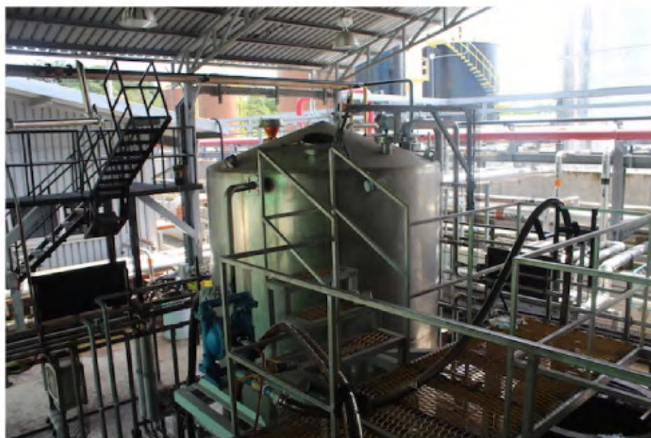
Figura 9.15: Tanque de almacenamiento de aguas residuales pre-tratadas. Fuente: Elaboración propia (2015)
